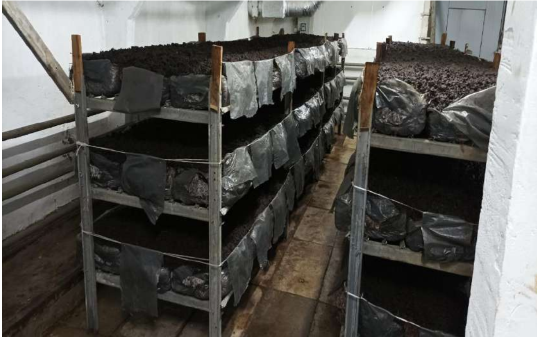
Рисунок 1. Камера выращивания с установленными трех ярусными стеллажами.
